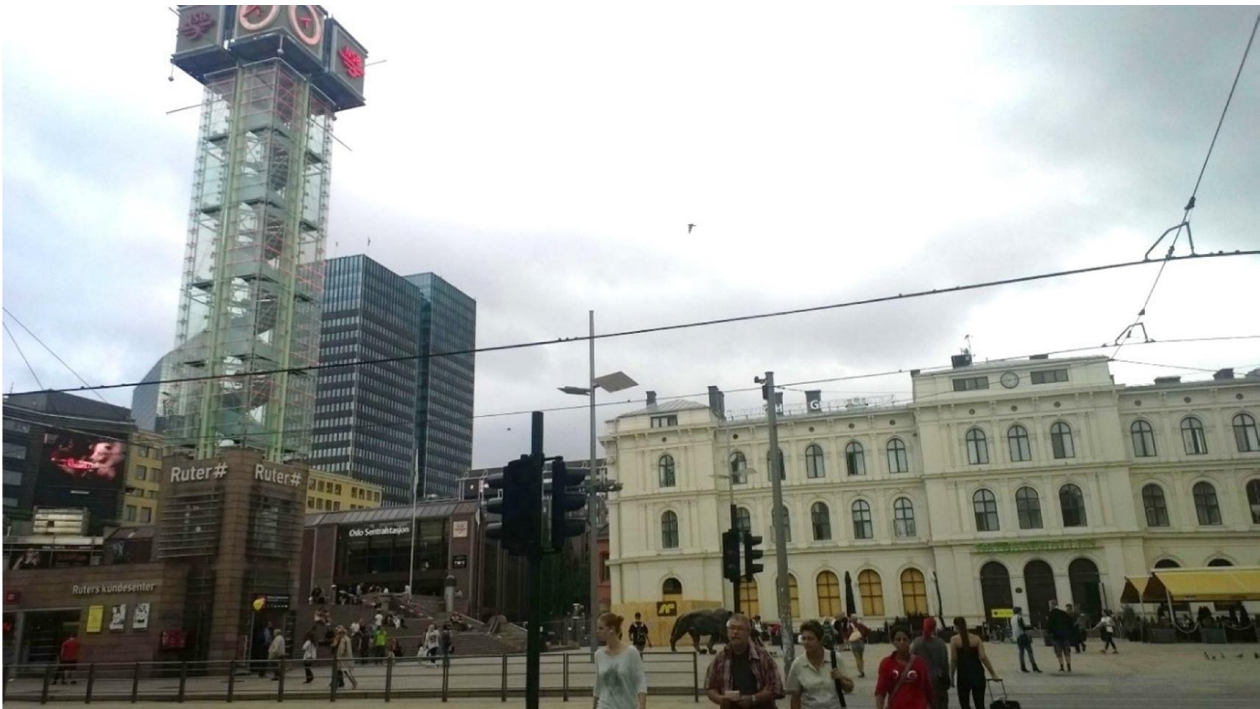
Foto 7 - Vecchia e nuova stazione a confronto: a destra la Østbanen stasjon, a sinistra la Sentralstasjon sovrastata da grattacieli. La torre in primo piano ospita alla base il "Trafikanten", un ufficio informazioni e biglietteria sia per i treni che per il trasporto locale ad Oslo. Vende anche libri e cartoline ferroviarie
